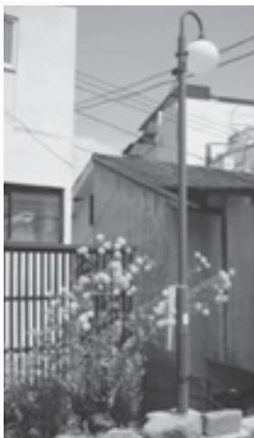
LED化された街路灯
