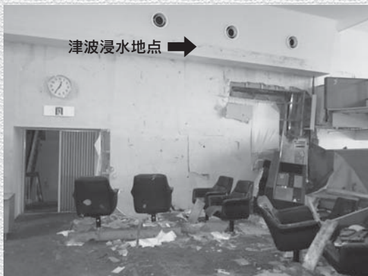
被災した役場庁舎の内部 矢印部分まで津波に襲われた
