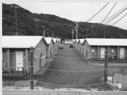
完成した仮設住宅
