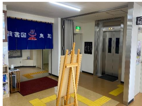
エレベーターが設置されました
