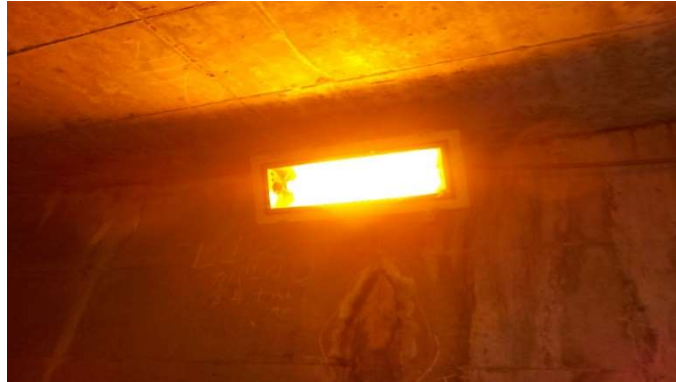
写真 6 付属施設（トンネル入り口付近）
