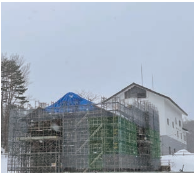
▲建設中の下水処理場
