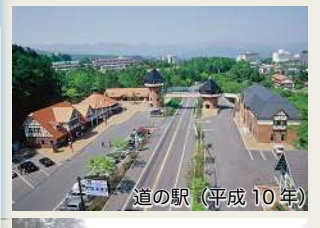
道の駅（平成 10 年）
