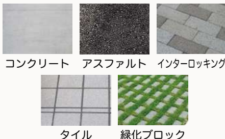
駐車場舗装面の例
