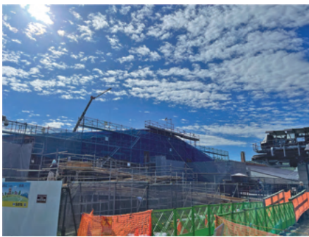
▲工事中の天狗山レストハウス
