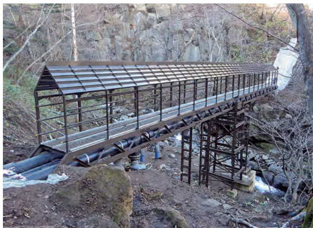
←新しくなった水管橋
