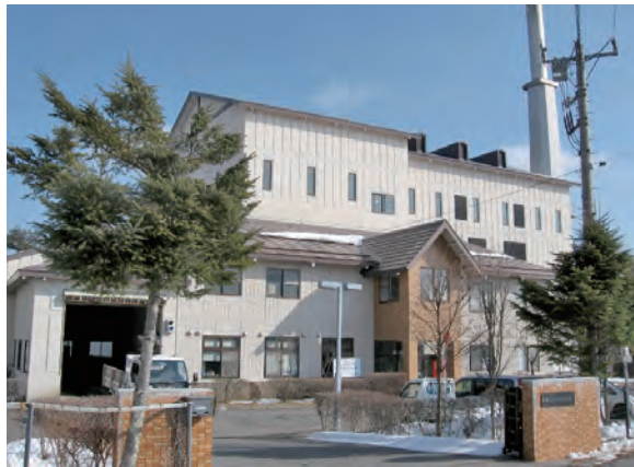
28年が経過したクリーンセンター
