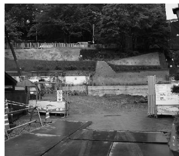
御座之湯建設現場
