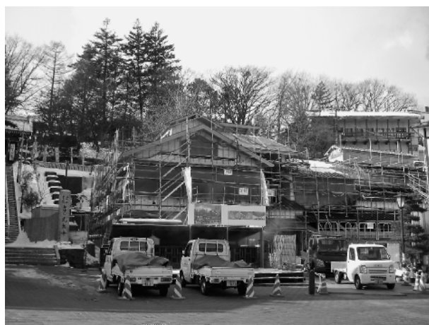
建設が進む御座之湯
