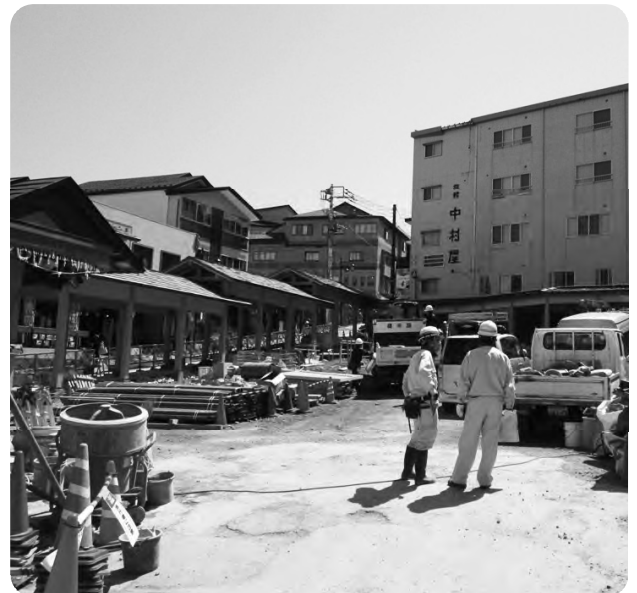
工事が進む湯畑「湯路広場」
