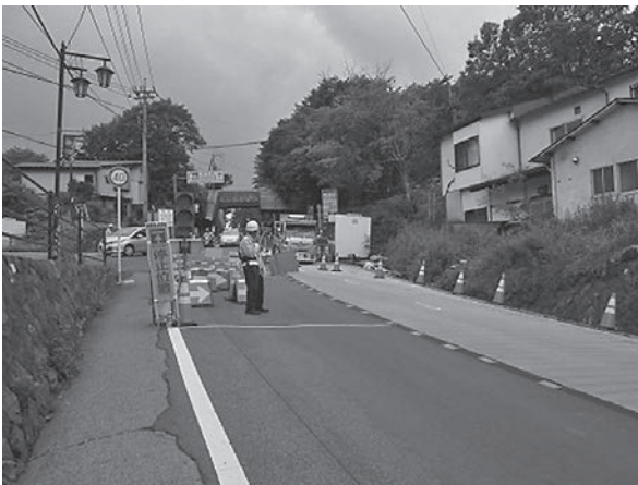
12月まで工期予定の国道292号線融雪工事
