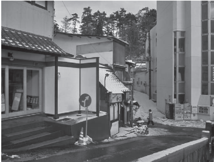
地下埋設ですっきり
