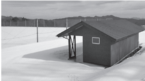
新設された第5グラウンドのトイレ
