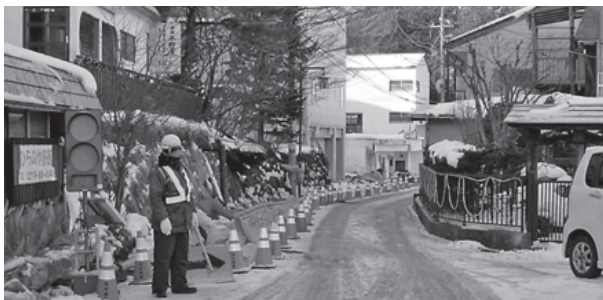
工事中の町道馬場舟の尻線
