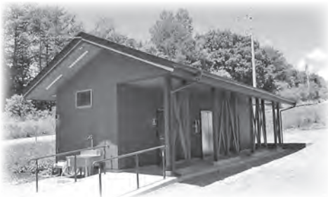
新設されたトイレ（第5グラウンド）
