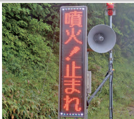
噴火時に警告表示する電光掲示板とサイレン
