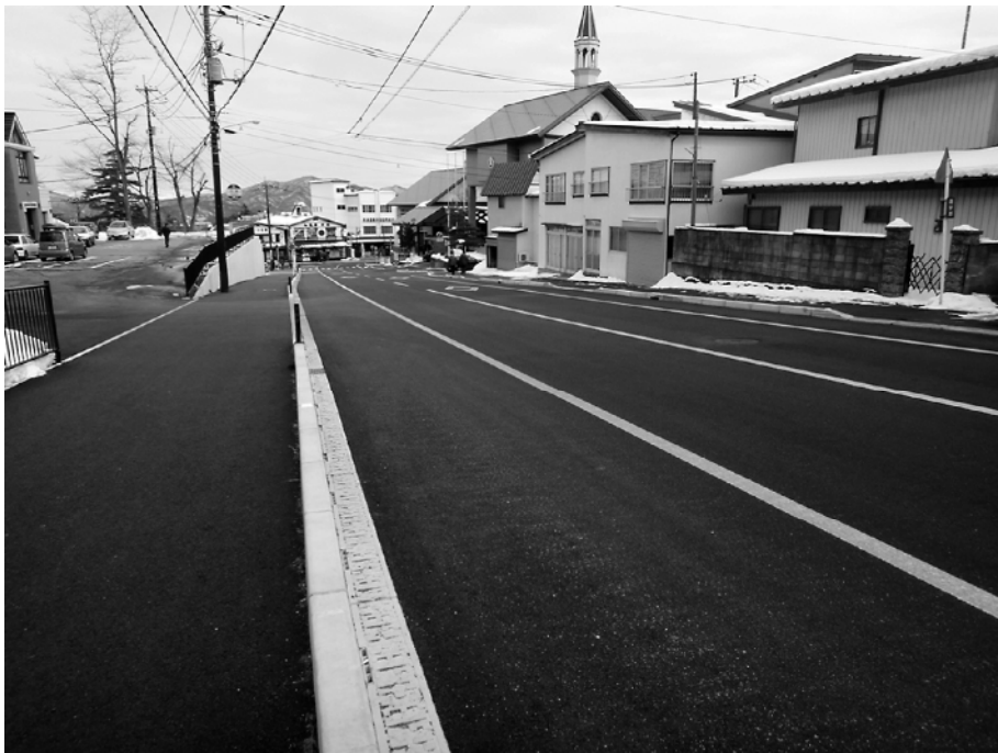
完成した役場前国道292号
