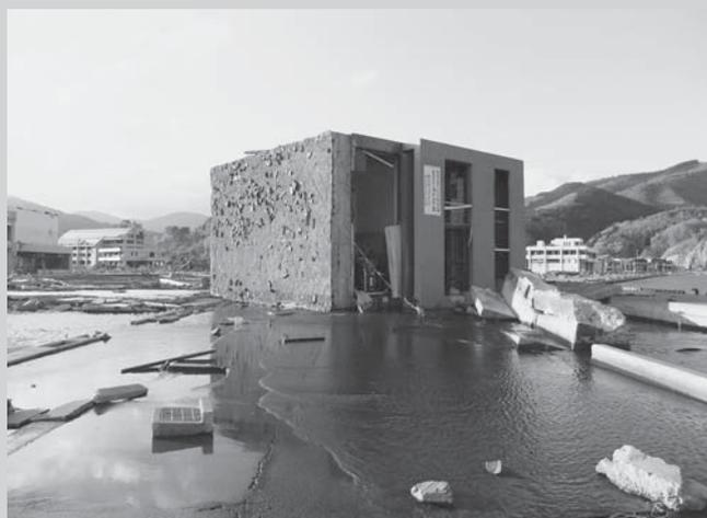
港近くにある津波で倒壊した建物 左の面が基礎部分
